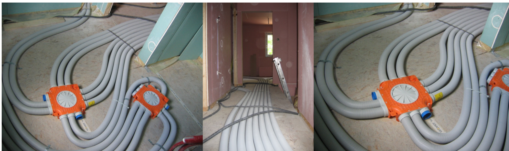
Kanały R-VENT Flex System to nowoczesne, całkowicie schowane w przegrodach budowlanych przewody wentylacyjne. Na zdjęciu kanały przygotowane do zalania w posadzce.
