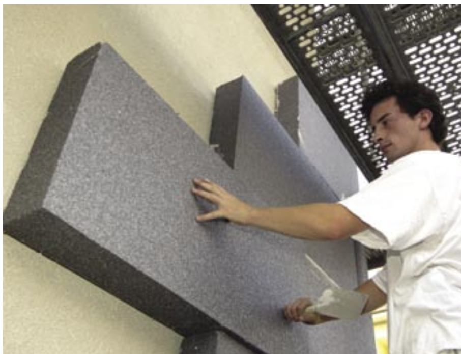
Das Neopor wird an die Fassade geklebt. Der Handwerker fixiert durch kräftigen Händedruck die Dämmplatte. Anschließend wird der Dämmstoff verdübelt.
